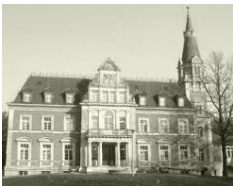
Dawny widok pałacu na Pawłowicach
